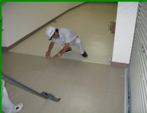
②汚損防止養生
