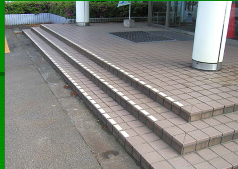
滑り止めテープの貼付け
