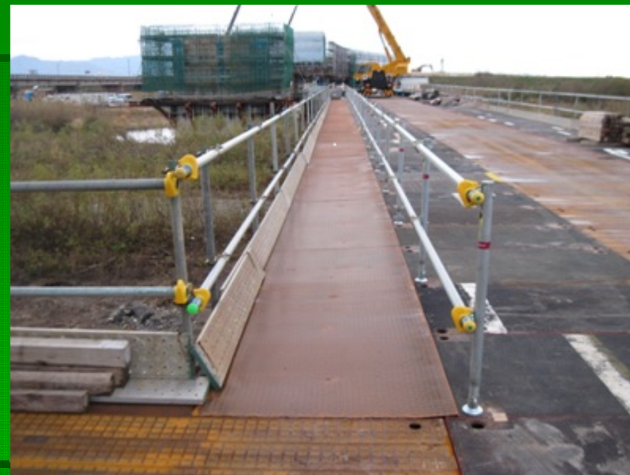
旭橋上部工工事 仮設通路 2013年11月 146m 2
