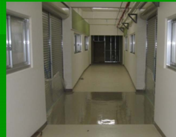
⑥養生・完成
