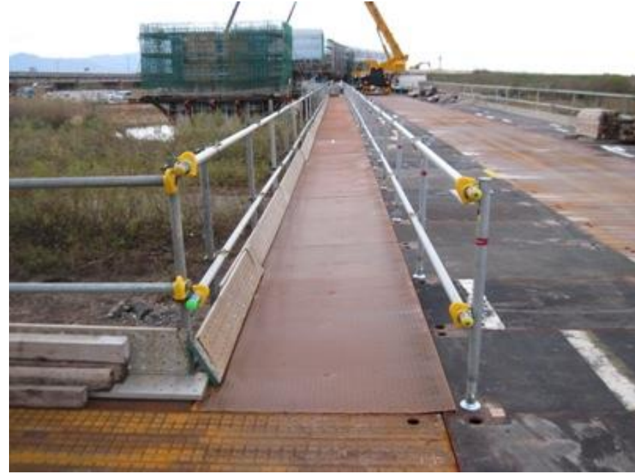
旭橋上部工工事 仮設通路 2013年11月 146m 2
