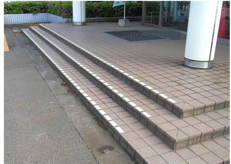
滑り止めテープの貼付け
