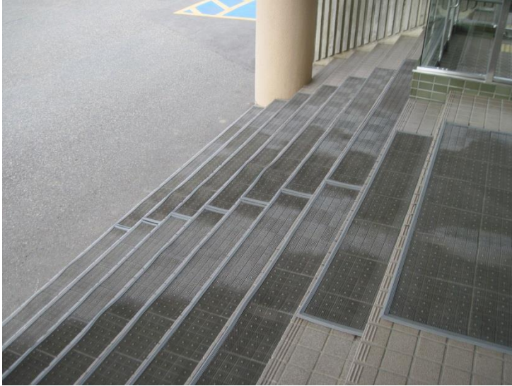
滑り止めマットの敷設
