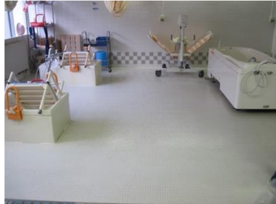
長岡市 特養ホーム浴室
