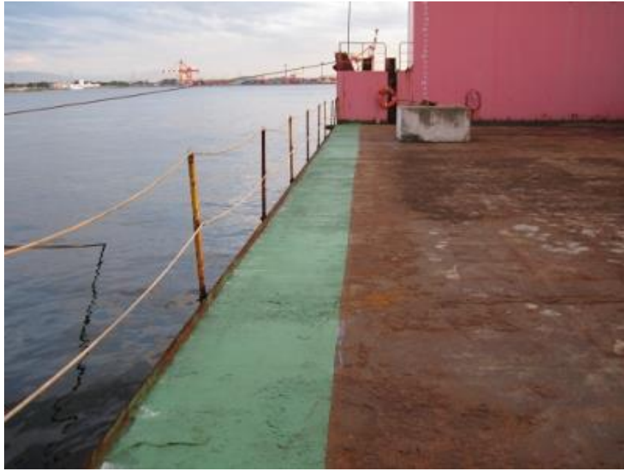
東港ケーソン製作台船甲板 2013年8月 70m 2
