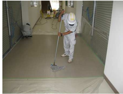
② 洗浄作業
