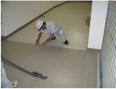
① 養生作業
